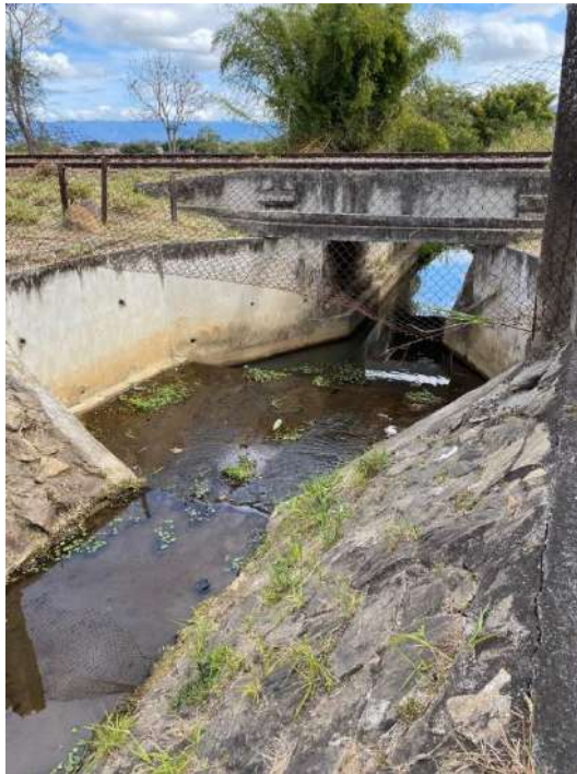
FIGURA 45 – PONTO 02 – TRAVESSIA NA LINHA FÉRREA FONTE: ACERVO DO AUTOR, 2023
