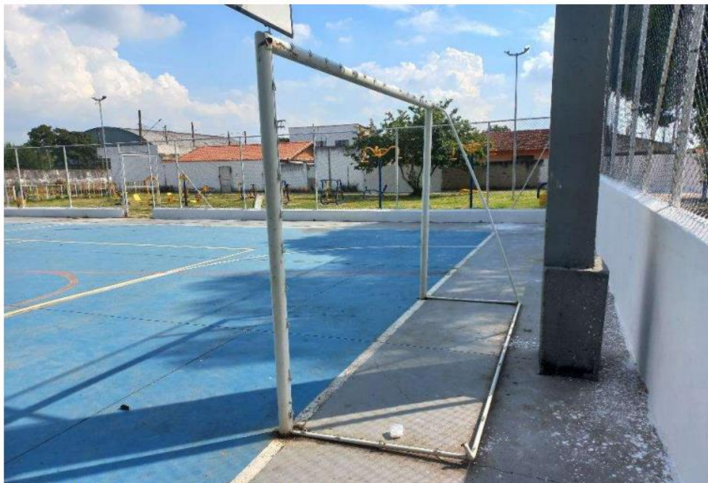
FOTO 10 - Trave de futsal que será substituída
