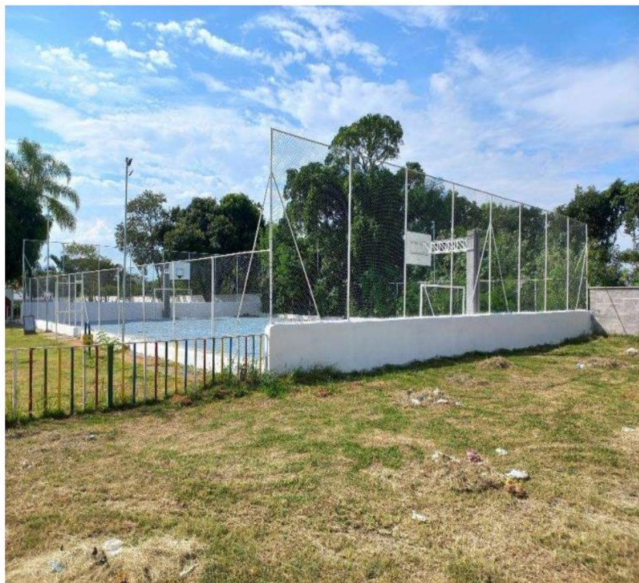
FOTO 1 - Vista geral externa da quadra
