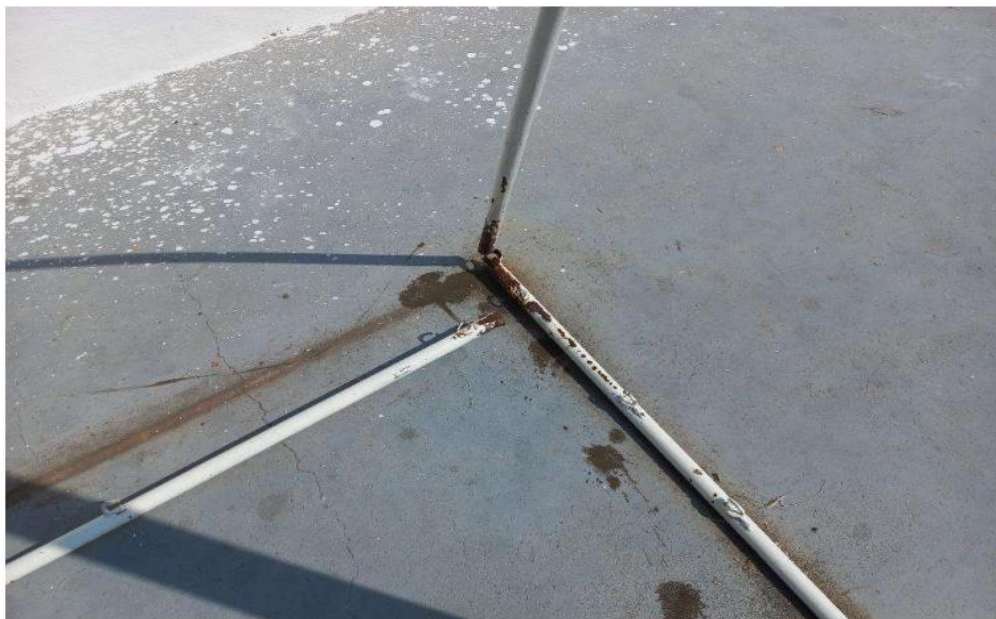
FOTO 6 - Trave de futsal que será substituída
