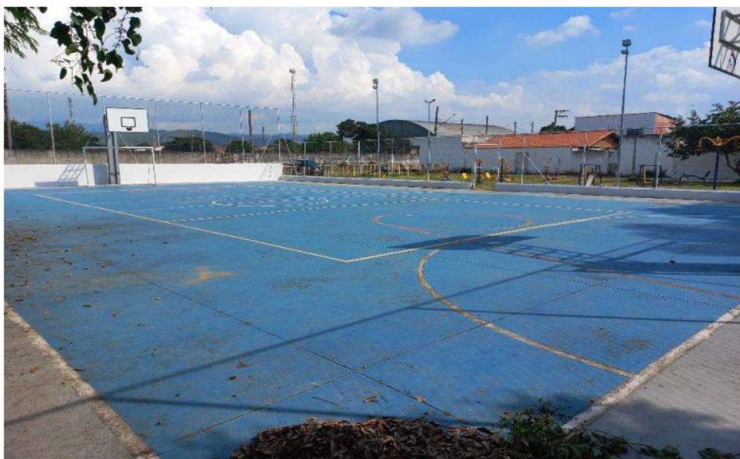
FOTO 9 - Vista geral interna da quadra
