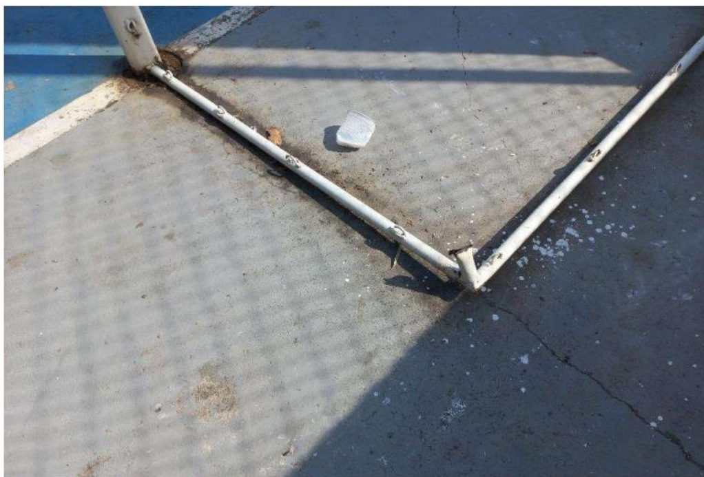
FOTO 11 - Trave de futsal que será substituída
