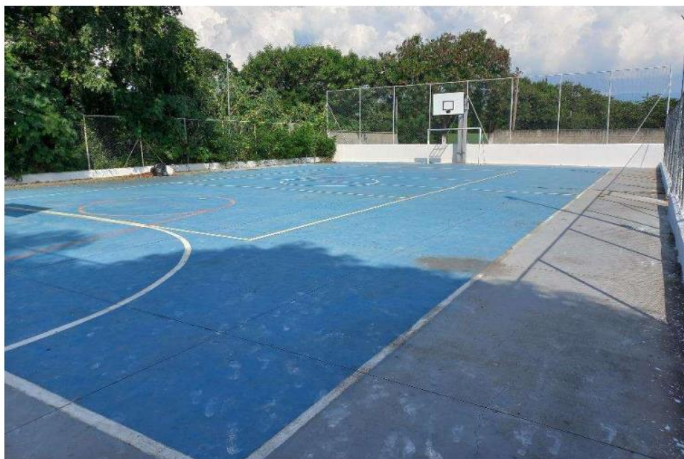
FOTO 13 - Vista geral interna da quadra
