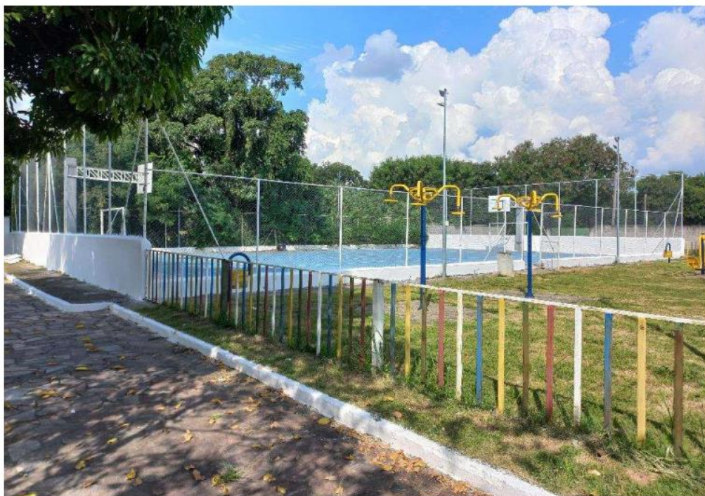
FOTO 14 - Vista geral externa da quadra
