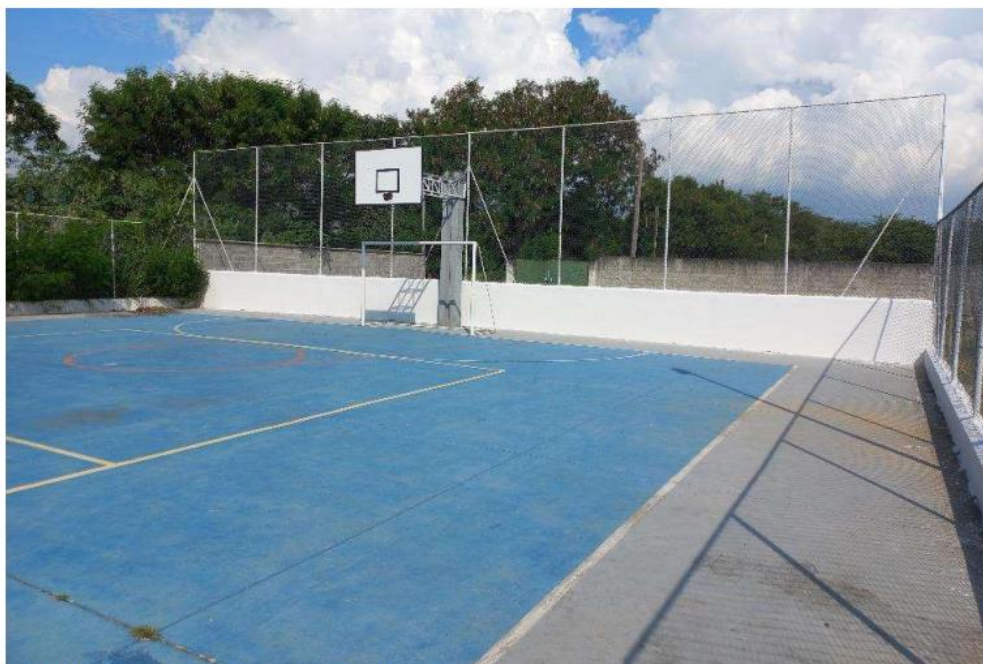
FOTO 4 - Vista geral interna da quadra
