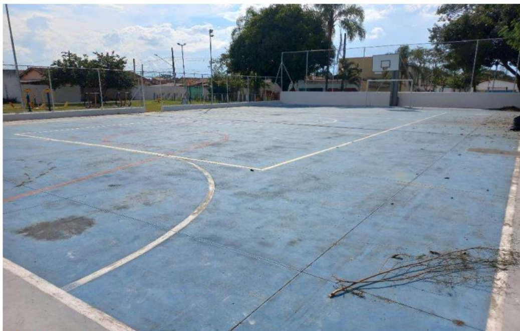
FOTO 8 - Vista geral interna da quadra
