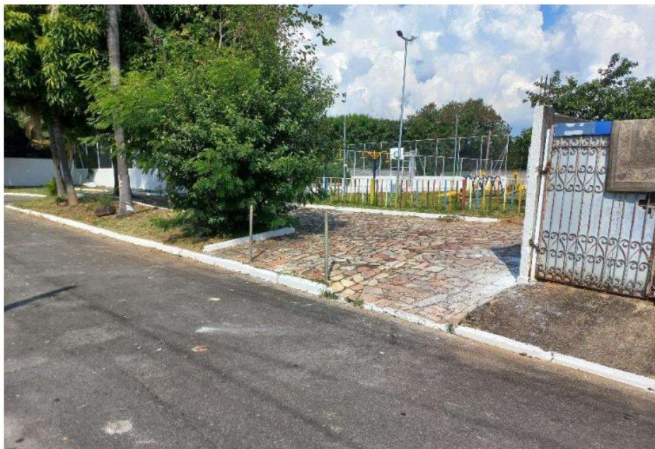
FOTO 16 - Rampa de acessibilidade existente
